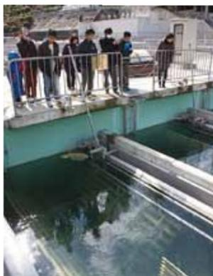
フロック形成池で細かいごみや細菌を固まらせて沈めさせる
