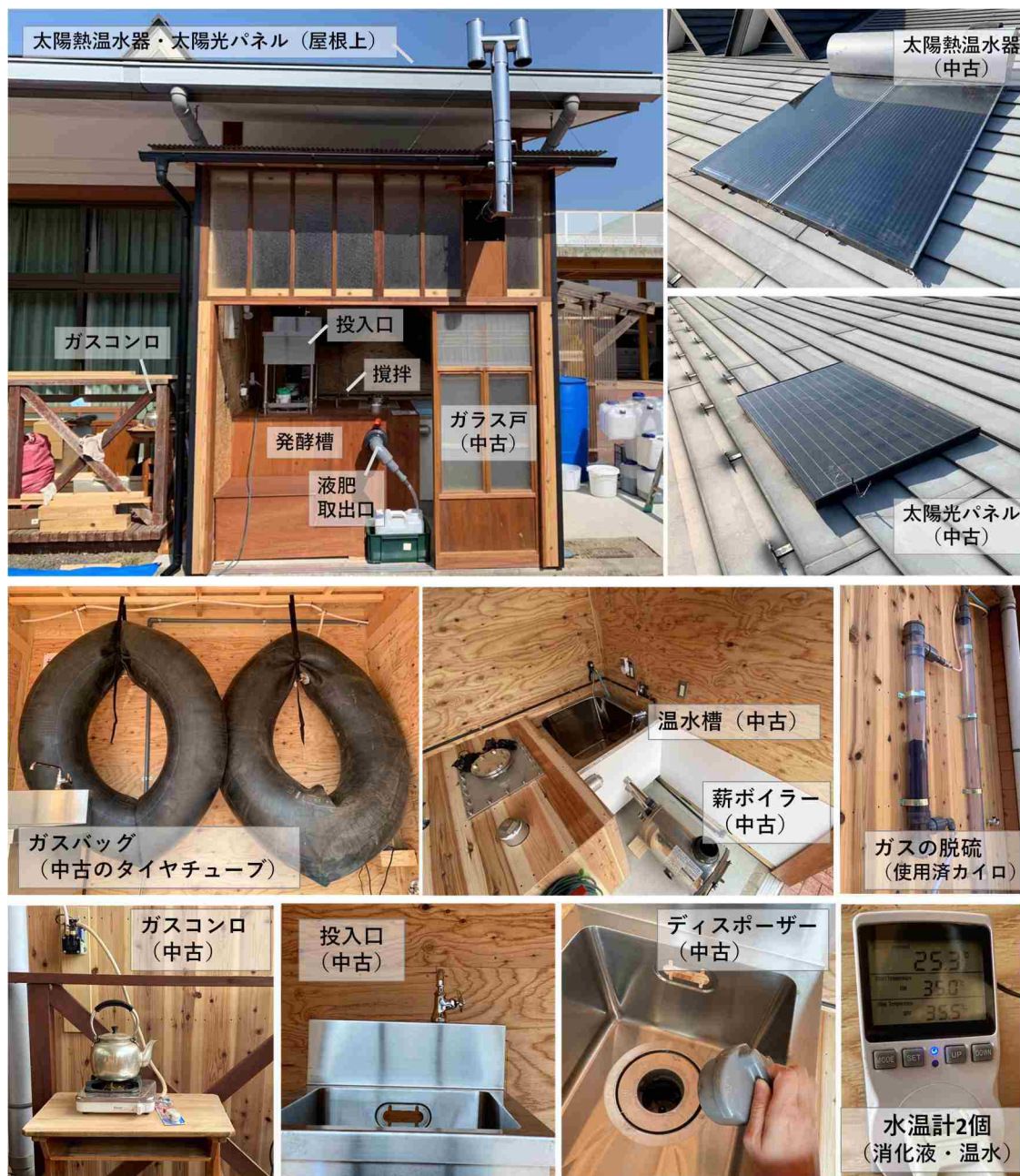
図 35 バイオガスプラントの機能
