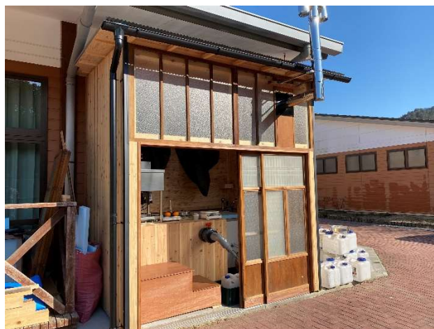
図 17 超小型バイオガスプラント
